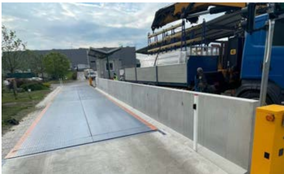
Izdelava tehtnice za tovorna vozila na CERO Pragersko
