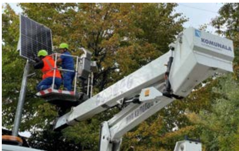
Montaža solarne svetilke
