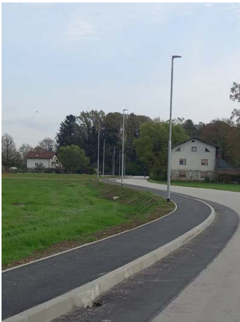
Izgradnja pločnika v Starem Logu
