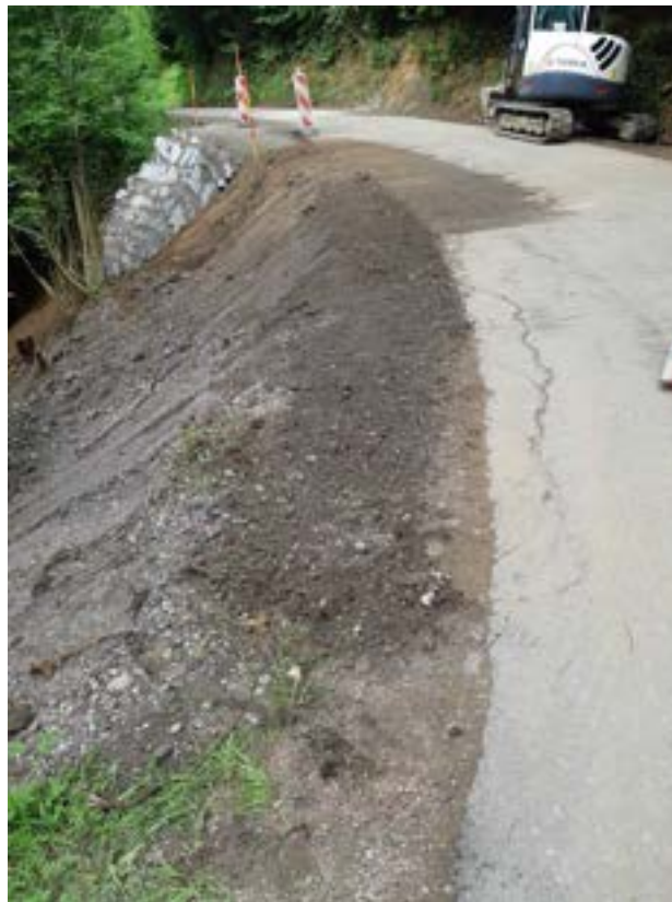
Sanacija brežine na lokalni cesti Tri Cerkev - Areh
