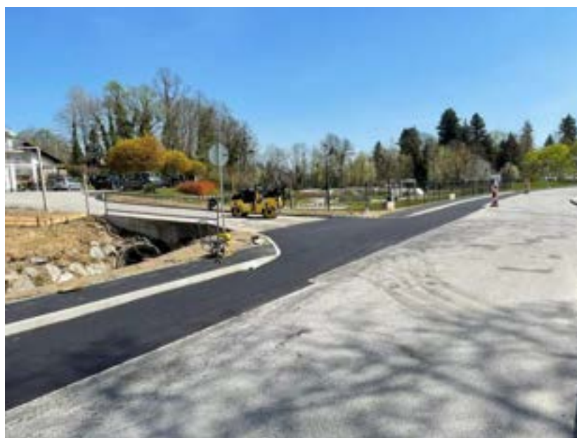
Izgradnja pločnika na Kraigherjevi ulici v Slovenski Bistrici
