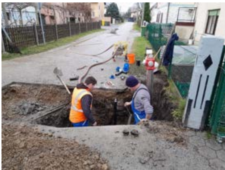
Montaža novega hidranta za KS Pragersko
