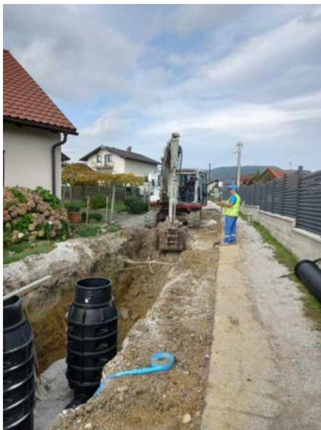
Izgradnja FK in MK ter vodovoda na Kajuhovi ulici
