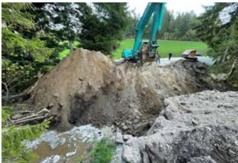
Izdelava novega prepusta na lokalni cesti Kebelj - Osankarica
