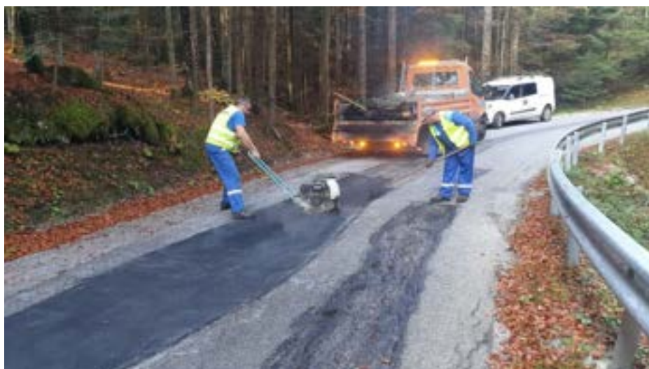
Krpanje poškodb asfalta na lokalni cesti Tinje - Planina
